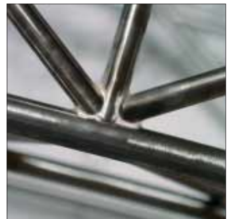
Der Bau von Stahlrohrrümpfen bedarf zwar etwas Übung, aber wenn man die hat, kommen solche Lötstellen dabei raus
